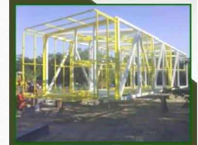
APLICACIÓN DE PROTECCION ANTICORROSIVA (SANDBLAST,RP-23,RI-41YRA-35) DE ACUERDO A REQUERIMIENTO DEL SISTEMA 12 A 2 ESTRUCTURAS DE ACCESO RIG-80S.
