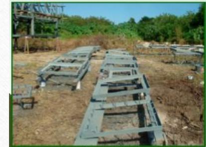
APLICACIÓN DE PROTECCION ANTICORROSIVA (SANDBLAST,RP-4BYRA-35) DEACUERDO A REQUERIMIENTO DEL SISTEMA 04 A SOPORTES DE COLUMNAS EN COMISARIA DE TERMINAL MARITIMA "LAGUNA AZUL" PEMEX (TRABAJOS REALIZADOS PARA CMT CONSTRUCCIONES DE CAMPECHE).
