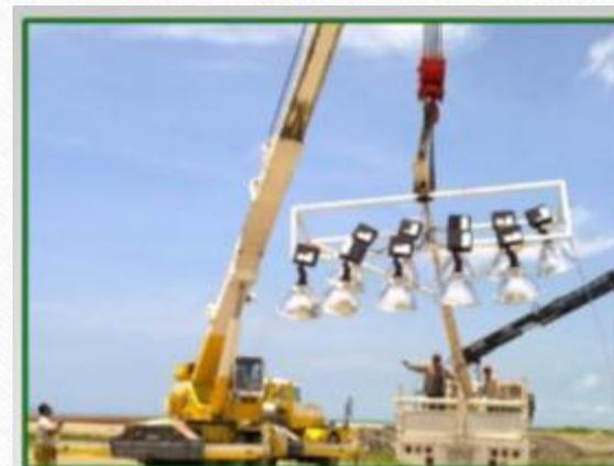
SUMINISTRO E INSTALACIÓN DE LUMINARIA TIPO POSTE CON 10 LÁMPARAS TIPO REFLECTOR EN AREA DE ESTACIONAMIENTO DEL DOMO DEL MAR, UBICADO EN AV. BOULEVARD COSTERO MOURIÑO, CD. DEL CARMEN, CAM. (TRABAJOS REALIZADOS PARA H. AYUNTAMIENTO DEL CARMEN)
