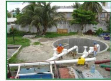
COLOCACIÓN, ALINEACIÓN Y TENDIDO DE TUBERÍA DE 48"Ø, CARCAMOS DE REBOMBEO DE LAS COLONIAS SALITRAL Y SAN NICOLAS DE CD. DEL CARMEN. (TRABAJOS REALIZADOS PARA LAS CIA DIAZ IGA EN CARCAMOS DE REBOMBEO DE LA COLONIA SAN NICOLAS Y COL. SALITRAL).
