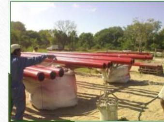
APLICACIÓN DE PROTECCION ANTICORROSIVA (SANDBLAST,RP-4BYRA-35) DE ACUERDO A REQUERIMIENTO DEL SISTEMA 04 A TUBERIA CON ACCESORIOS DE DIFERENTES DIAMETROS PARA COMISARIA DE TERMINAL MARITIMA "LAGUNA AZUL" PEMEX. (TRABAJOS REALIZADOS PARA LA CIA CMT CONSTRUCCIONES DE CAMPECHE)
