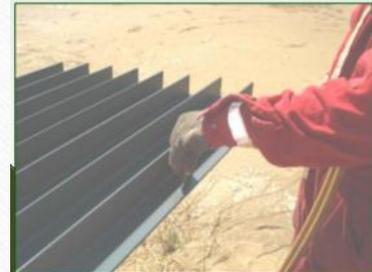
APLICACIÓN DE PROTECCION ANTICORROSIVA (SANDBLAST,RP-4BYRA-35) DE ACUERDO A REQUERIMIENTO DEL SISTEMA 04 A SOPORTES Y TRAMOS ANGULARES PARA COMISARIA DE TERMINAL MARITIMA "LAGUNA AZUL" PEMEX. (TRABAJOS REALIZADOS PARA LA CIA CMT CONSTRUCCIONES DE CAMPECHE)
