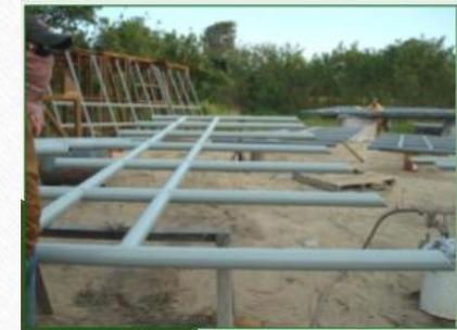
APLICACIÓN DE PROTECCION ANTICORROSIVA (SAND BLAST, RP-4 BYRA-35) DE ACUERDO A REQUERIMIENTO DEL SISTEMA 04 A BARANDALES TUBULARES DE 3" Ø PARA COMISARIA DE TERMINAL MARITIMA "LA GUNA AZUL" PEMEX.
