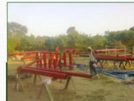
APLICACIÓN DE PROTECCION ANTICORROSIVA (SAND BLAST, RP-4 BYRA-35) DE ACUERDO A REQUERIMIENTO DEL SISTEMA 04 A TUBERIA CON ACCESORIOS DE DIFERENTES DIAMETROS PARA COMISARIA DE TERMINAL MARITIMA "LAGUNA AZUL" PEMEX
