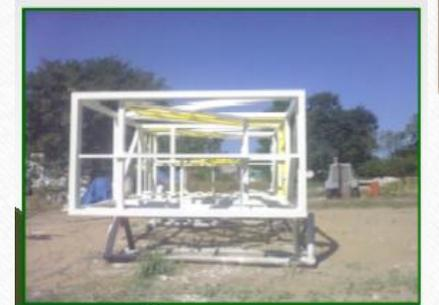
APLICACIÓN DE PROTECCION ANTICORROSIVA (SANDBLAST, RP-23, RI-41 Y RA-35) DE ACUERDO A REQUERIMIENTO DEL SISTEMA 12 A 2 ESTRUCTURAS DE ACCESO RIG-80S.
